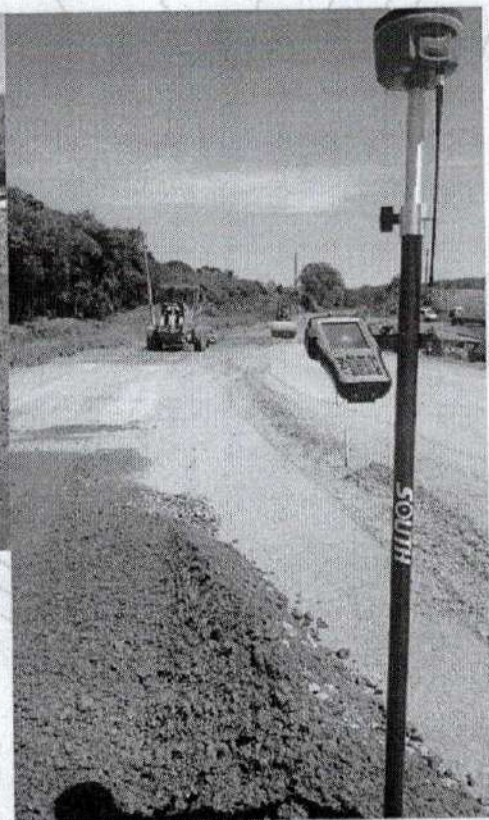
Locação Topográfica e acompanhamento de Obra de uma ponte sobre o Rio Andrada, situada em Boa Vista da Aparecida.
